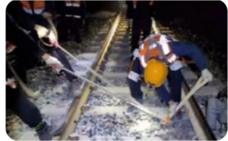
韩国铁道公社铁路作业现场
